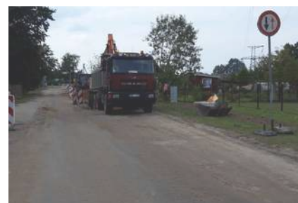
Pededzes ielā uzsākta asfalta ieklāšana
