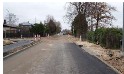
Pededzes ielā turpinās seguma ieklāšana
