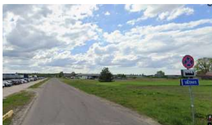
Notiek autoceļa C-30 gājēju celiņa, veloceliņa un apgaismojuma izbūves būvdarbi
