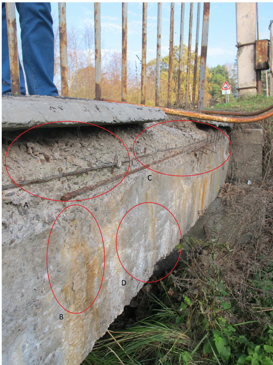
3.att. Pārseguma plātnes garenribas fasādes raksturīgie defekti
