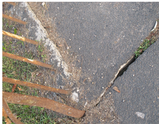
10.att. Plaisa asfaltā tiltiņa un uzbēruma sajūguma vietā
