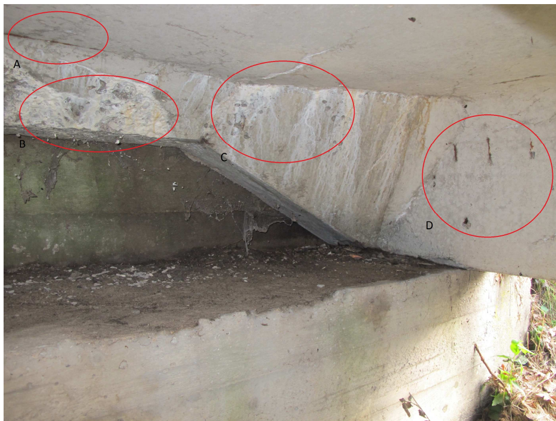
5.att. Pārseguma plātnes apakšējās daļas defekti pie balstā
