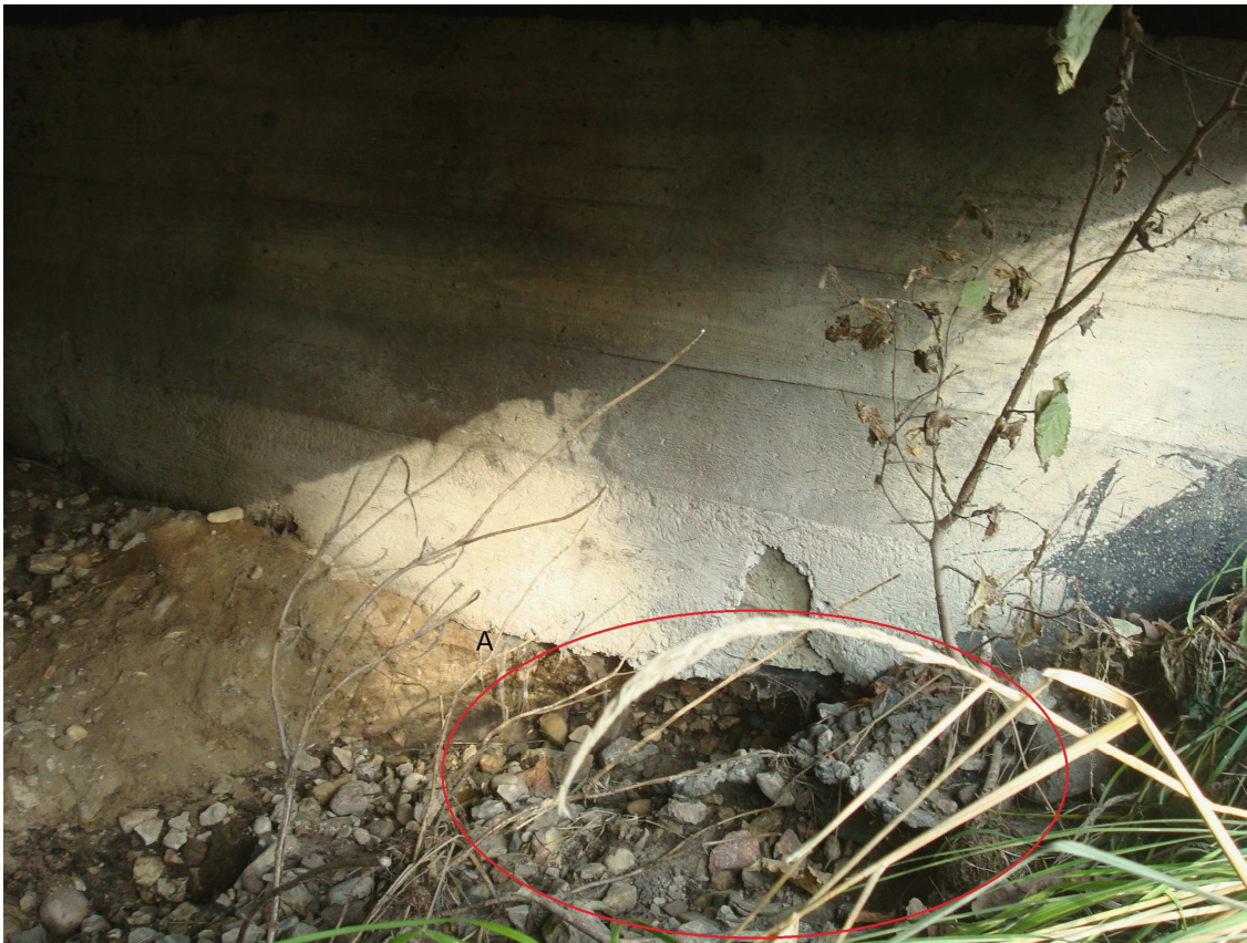
6.att. Grunts izskalošana pie balsta Nr.1
