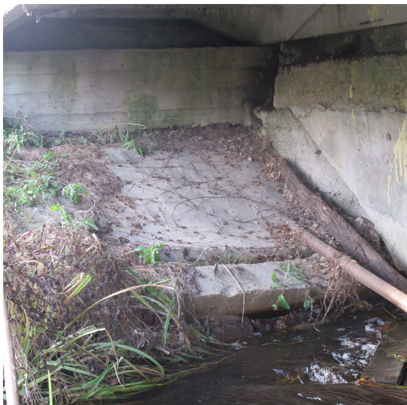
13.att. Konusa nostiprinājuma konstrukcija pie balsta Nr.2
