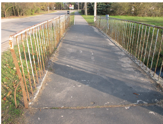
9.att. Asfaltbetona segums uz tilta
