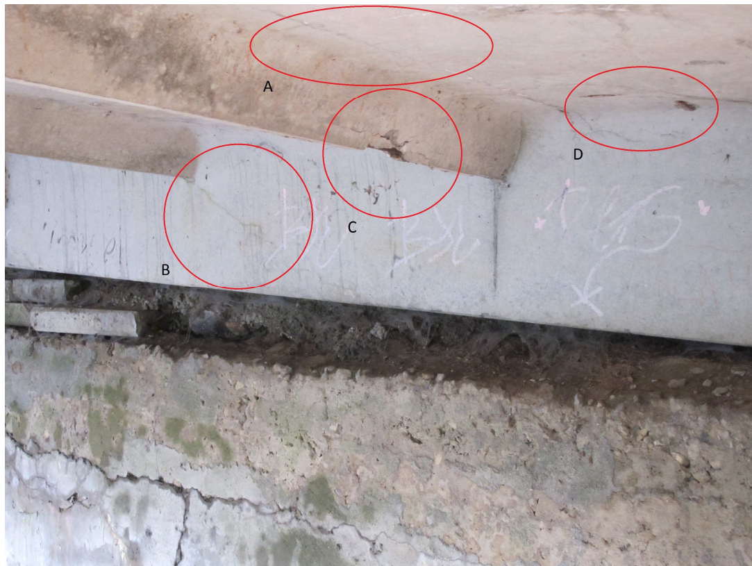
4.att. Pārseguma plātnes apakšējās daļas defekti laidumā
