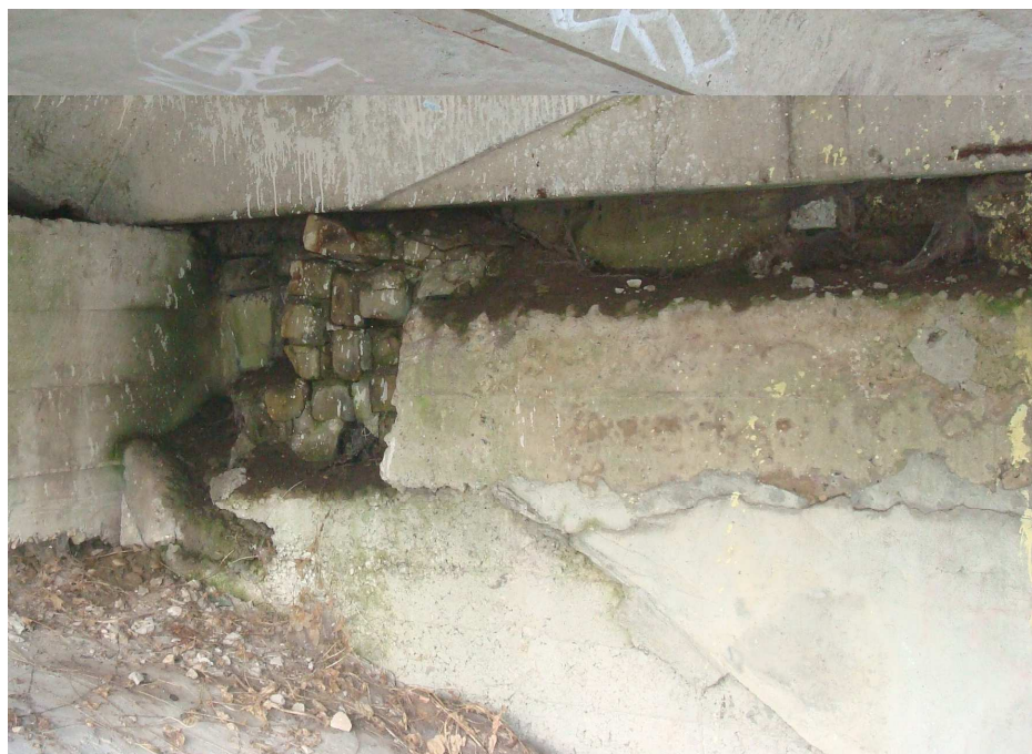
18.att. Caurtekas augšteces gala sienas konstrukcija pie balsta Nr.2
