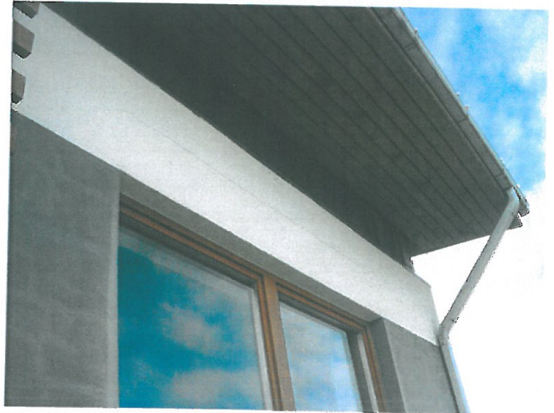
17. attēls. Peldbaseina jumta dzegas posms. Atrauti jumta zemējuma stiprinājumi.
