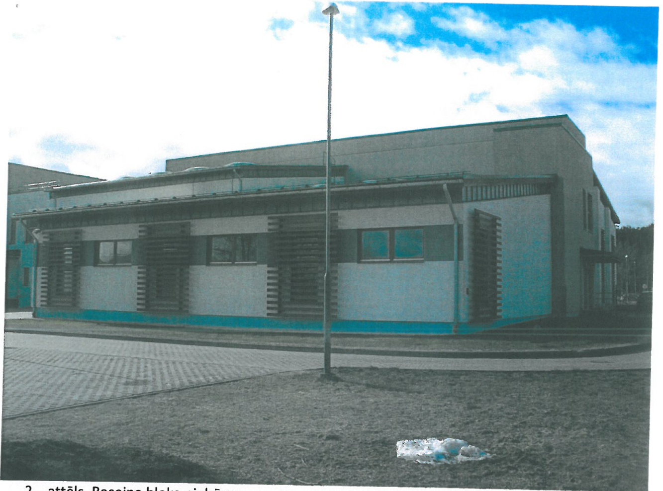
2. attēls. Baseina bloka piebūve.
