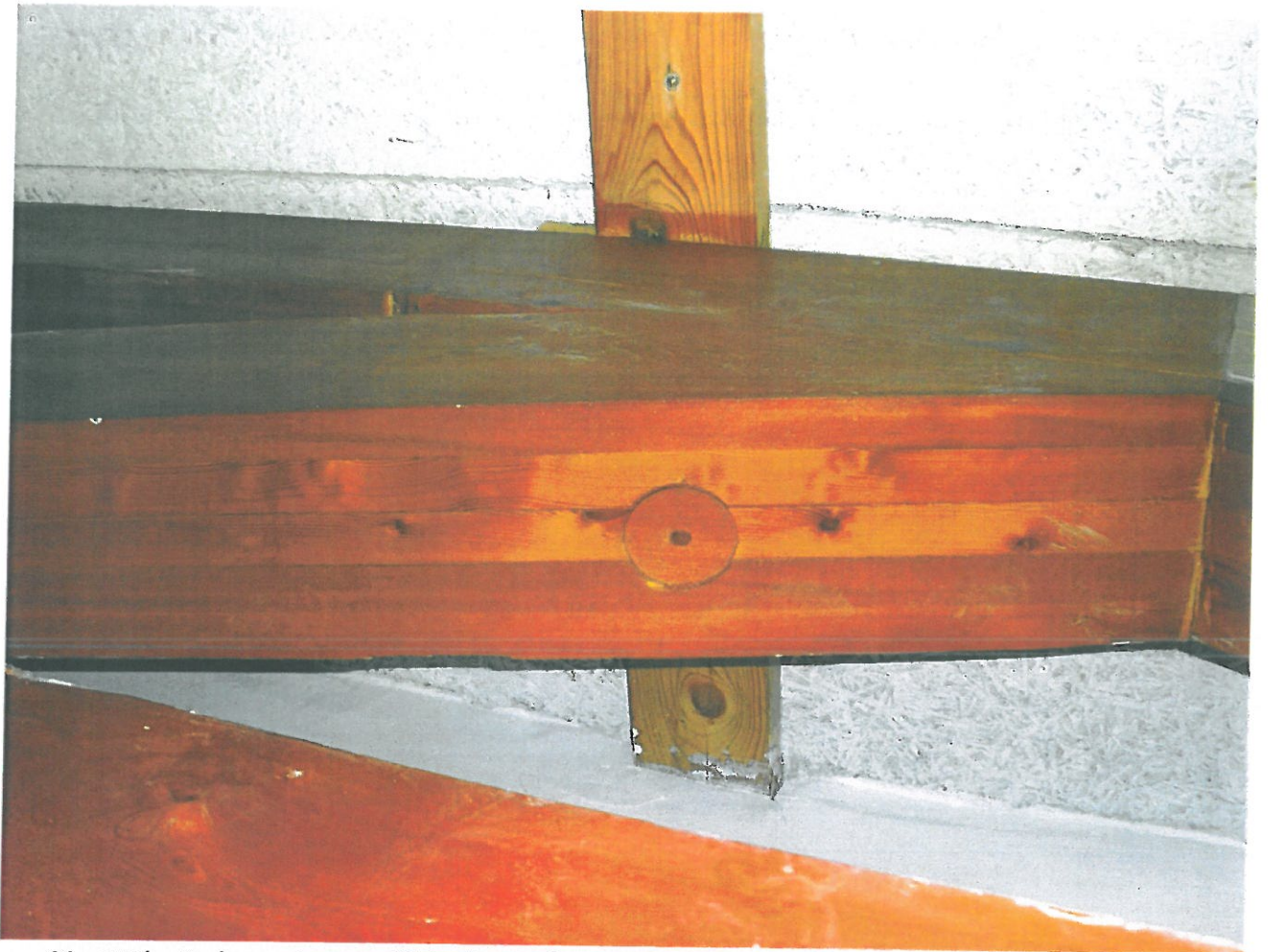
11. attēls. Redzams kopnes K-5 spiestā elementa pievienojuma mezgls augšjoslai.
