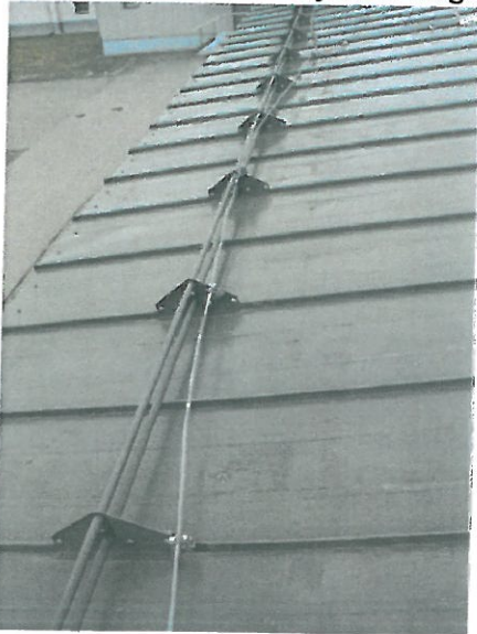
17. attēls. Peldbaseina jumta dzegas posms. Atrauti jumta zemējuma stiprinājumi.
