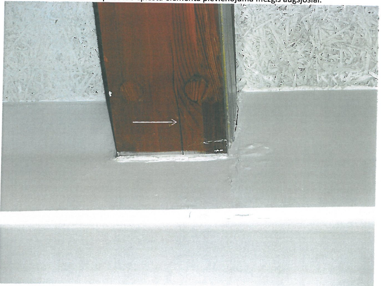
12. attēls. Plaisa kopnes K-5 balstmezglā apakšjoslā.
