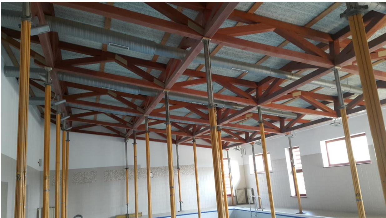
Baseina jumta nesošās konstrukcijas
