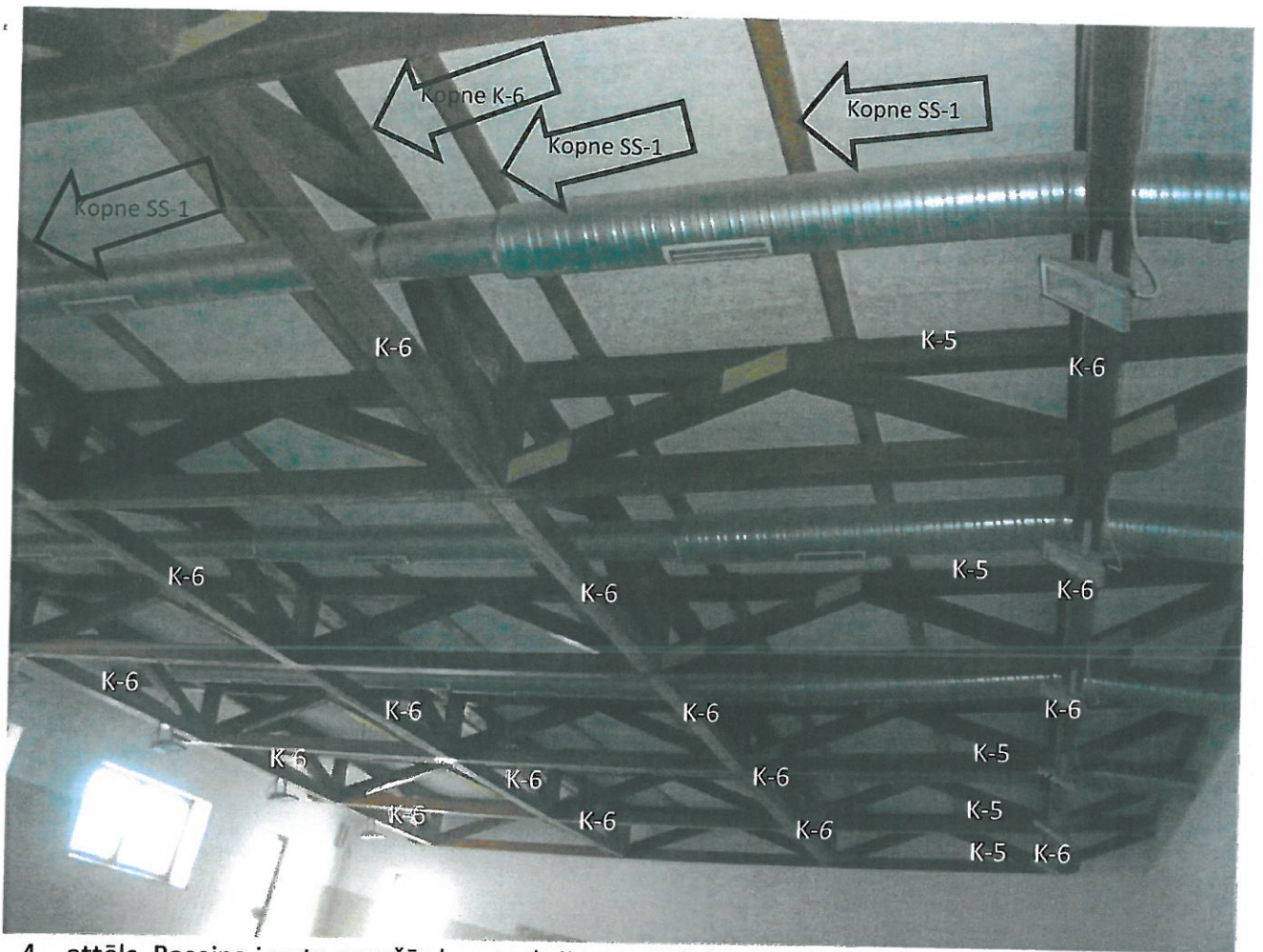
4. attēls. Baseina jumta nesošās konstrukcijas ar projektā pieņemto marķējumu.
